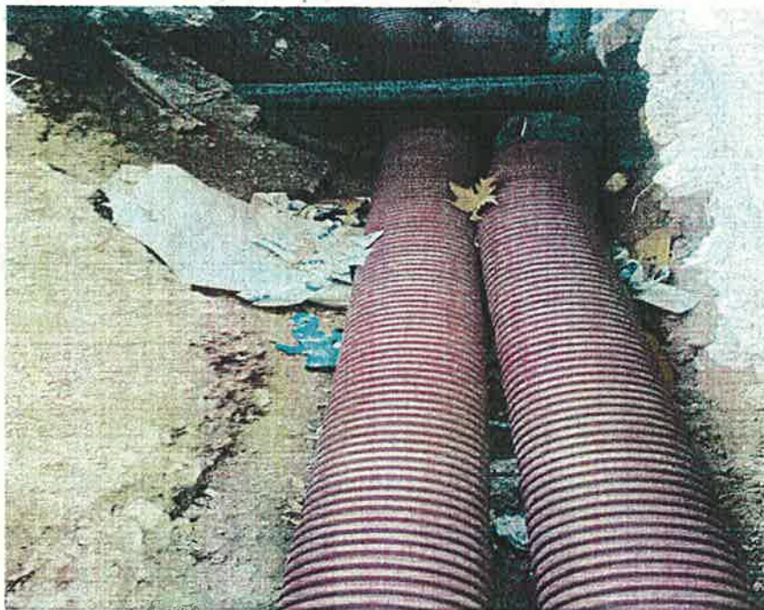
Preparativos de colocación de tubería sobre el lecho de la zanja, previo a la limpieza de la excavación.
