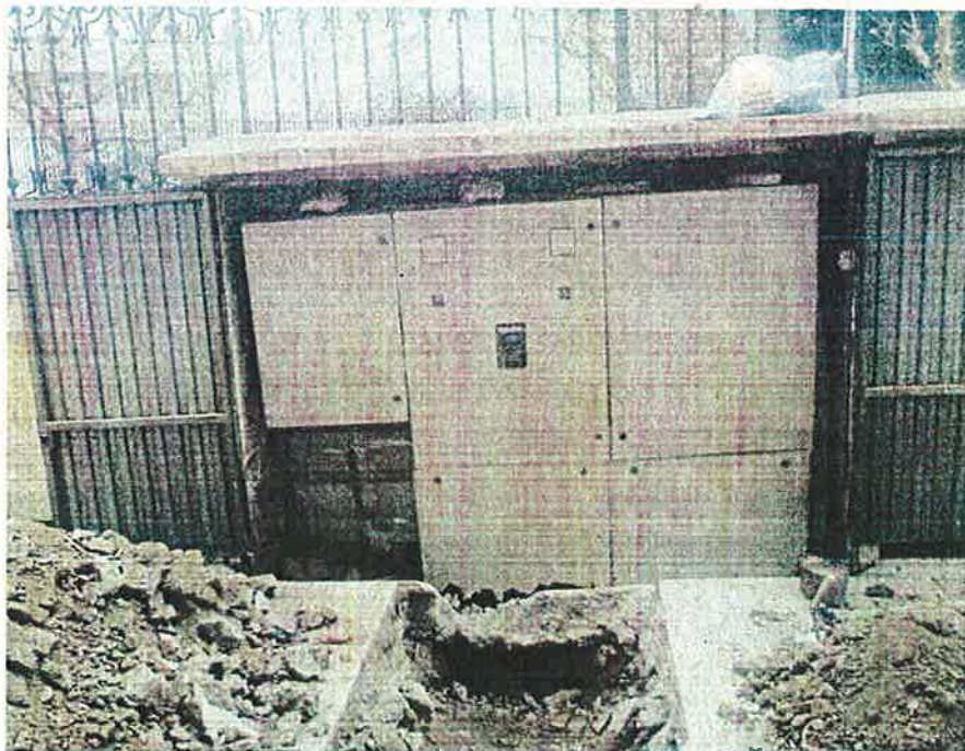
Frontal del cuadro eléctrico y detalle de la excavación con motivo de la sustitución de canalización eléctrica de acometida.
