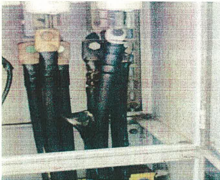
Fotografía ampliada en la que se ve el desprendimiento de capa aislante de terminal y alteración de conector de conductor perteneciente a una de las líneas de distribución que alimentan a edificios situados en el patio interior , lado Oeste
