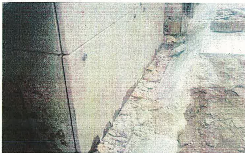
Fotografía que muestra el desnivel existente con respecto al plano de la rasante del suelo, así como la corrosión de la base de la envolvente de chapa.
