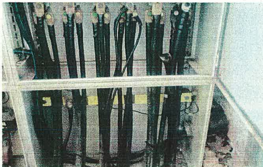
Detalle de líneas que forman la red de distribución en la que se observa la degradación de la cubierta de los cables
