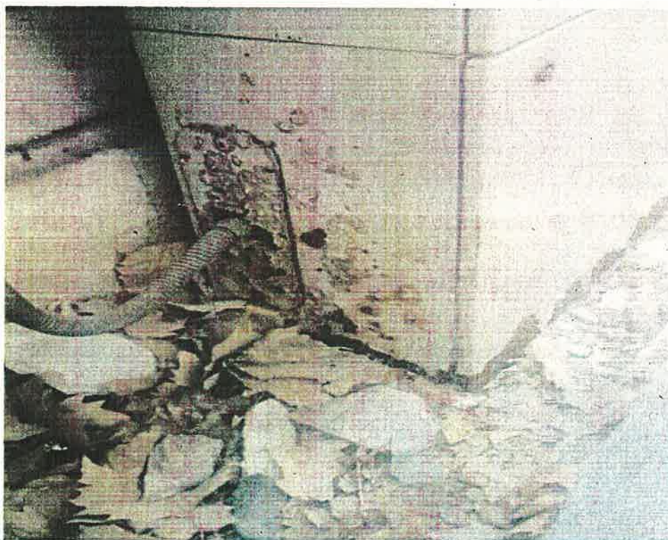
Detalle que muestra el grado de corrosión de la chapa de la envolvente del cuadro eléctrico del Cuartel de Palafox y de la acumulación de sedimentos en la base del cuadro.
